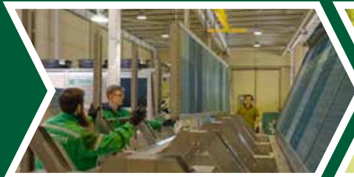
Сборка фрикулеров, установка вентиляторов и системы орошения
