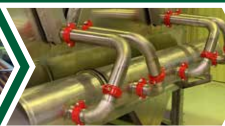
Разметка и сварка коллекторов (установка для вырубki отверстий, сварочная станция)
